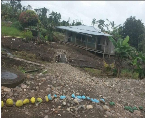
BARRIO 12 DE OCTUBRE / INPECCION DE PASO PEATONAL.
